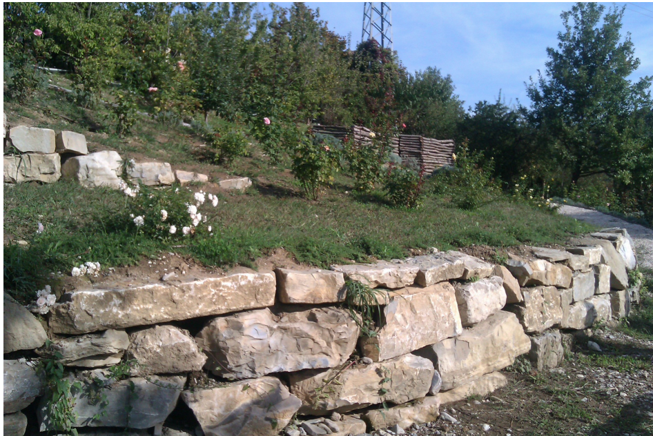
Foto 3: percorso pedonale del Museo della rosa nascente
