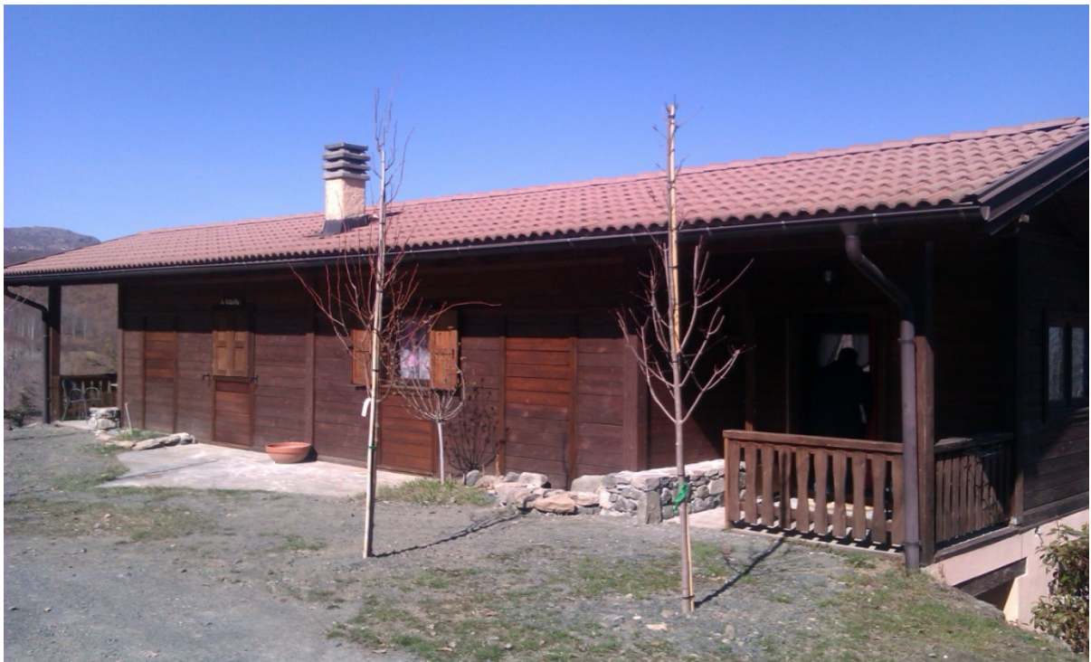
Foto 4: Zona servizi igienici e mini-appartamento
