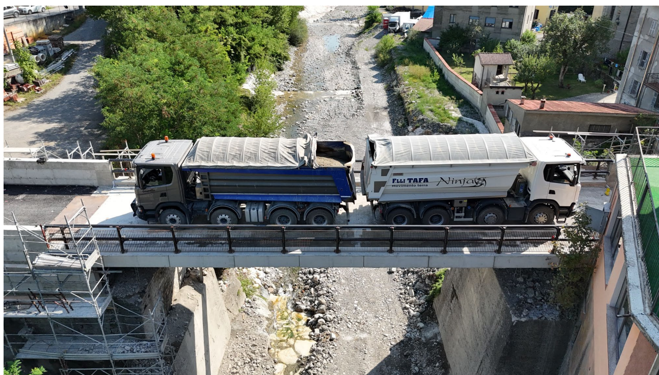
Ponte sul T. Grondana - Prove di carico
