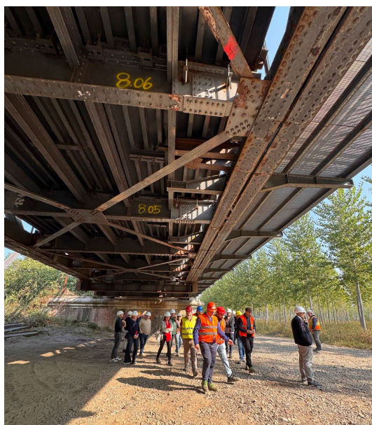
Sopralluogo al cantiere del Ponte
