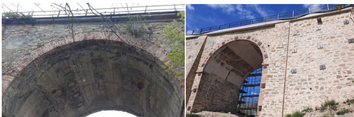
Ponte Lanzone – Prime e dopo l'intervento
