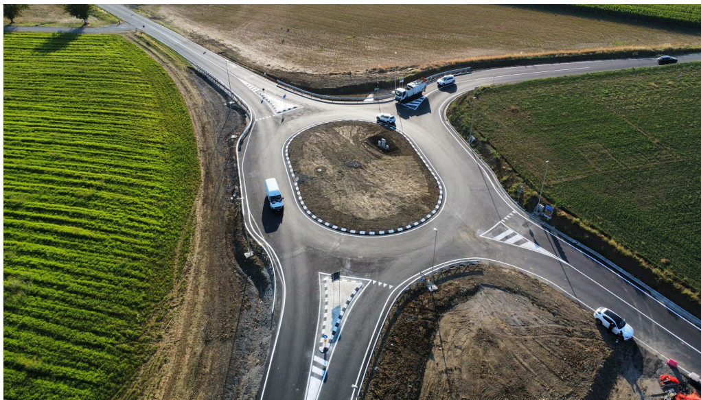
Rotatoria tra la Strada Provinciale n. 7 di Agazzano e le comunali per Rezzanello e Momeliano
