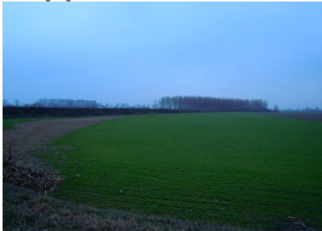
FOTO 3: Argine golenale in località C.na Motta verso monte
