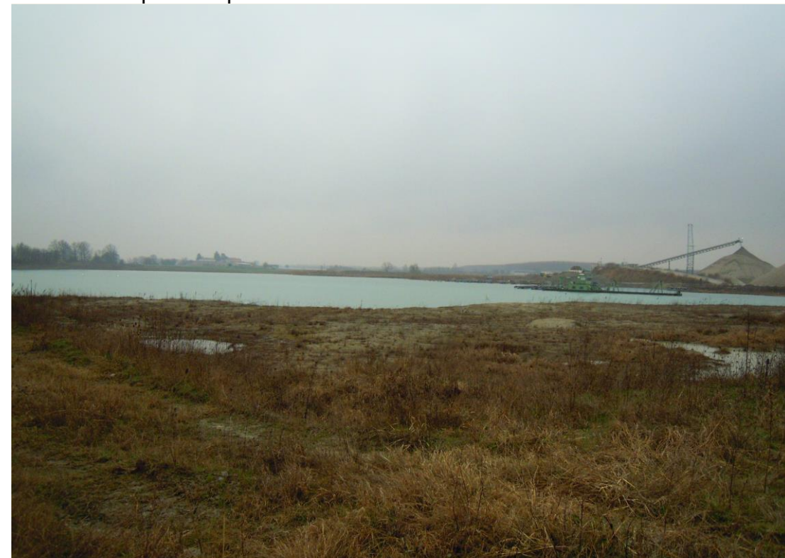
FOTO 4: Comparto A: panoramica areale di intervento
