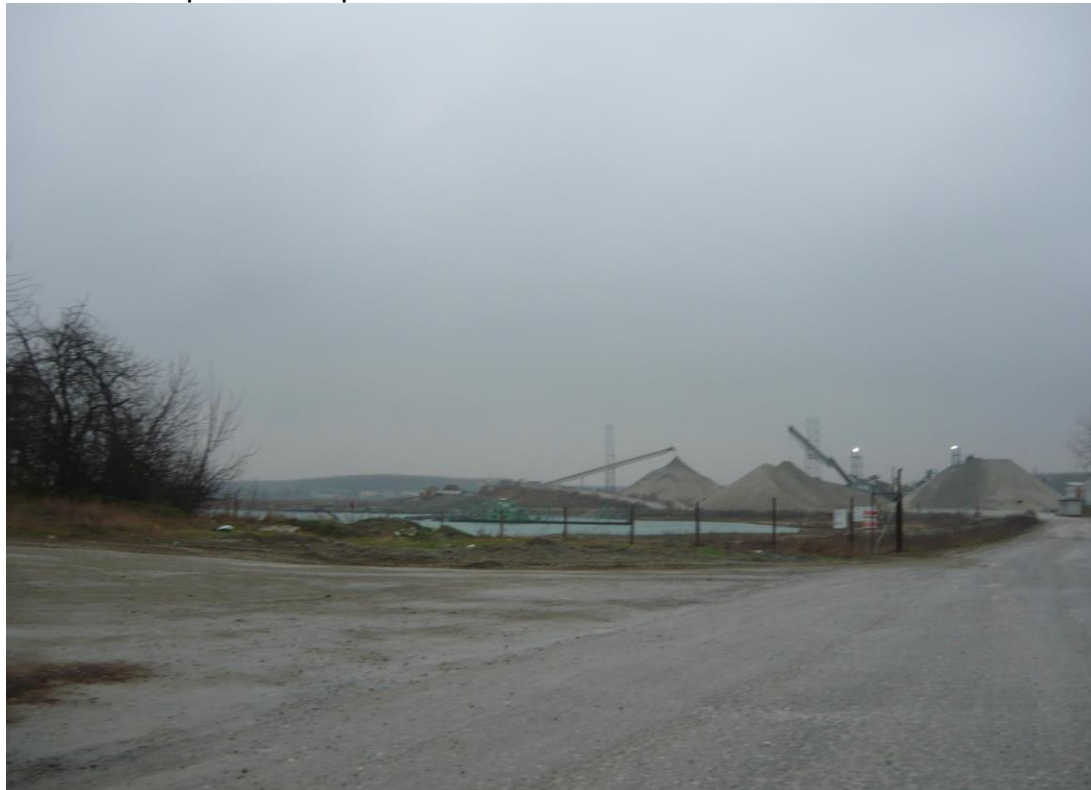
FOTO 1: Comparto A: impianti di lavorazione inerti
