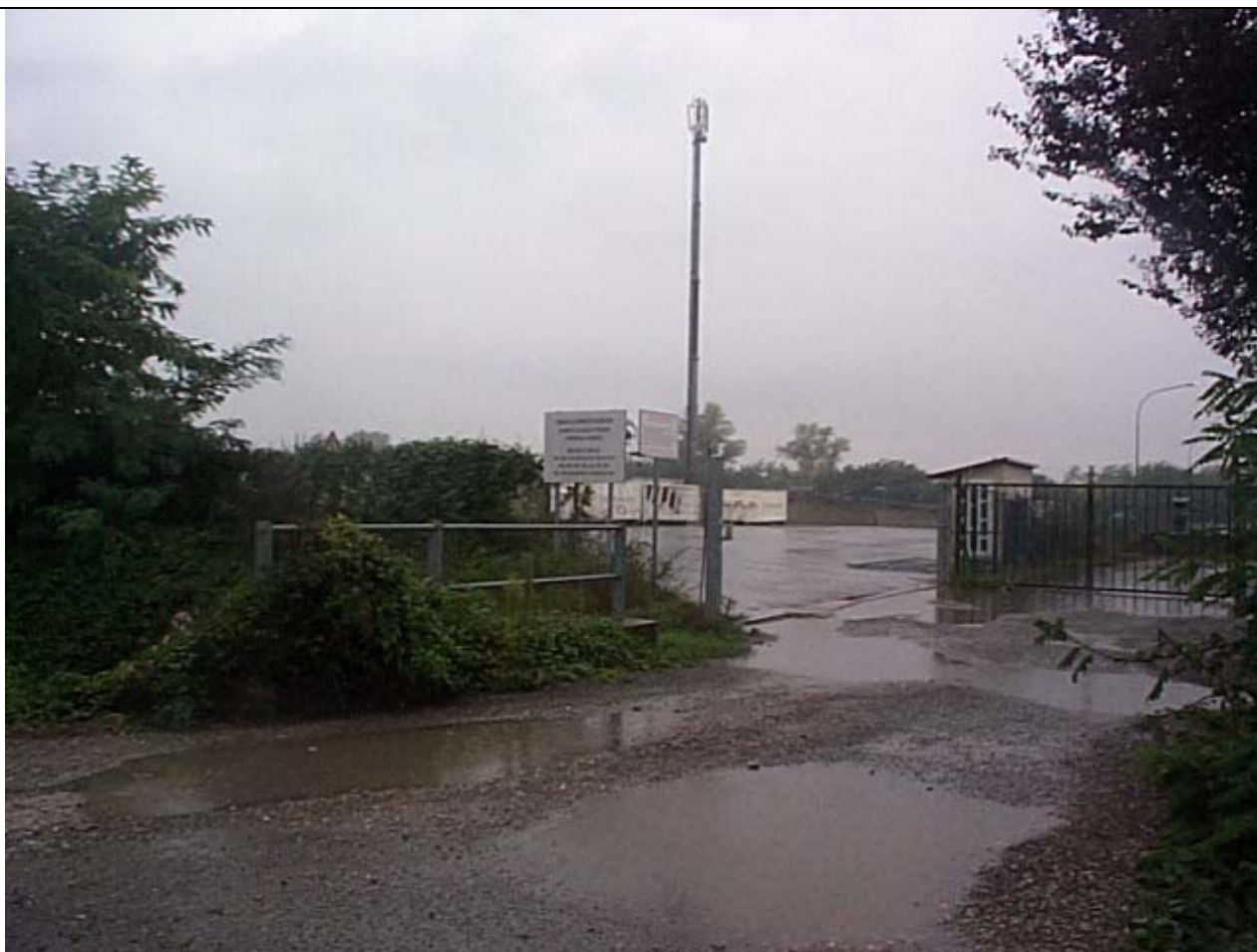
FIGURA 1: panoramica della SRB da Strada del Canalone (ingresso della stazione ecologica attrezzata)
